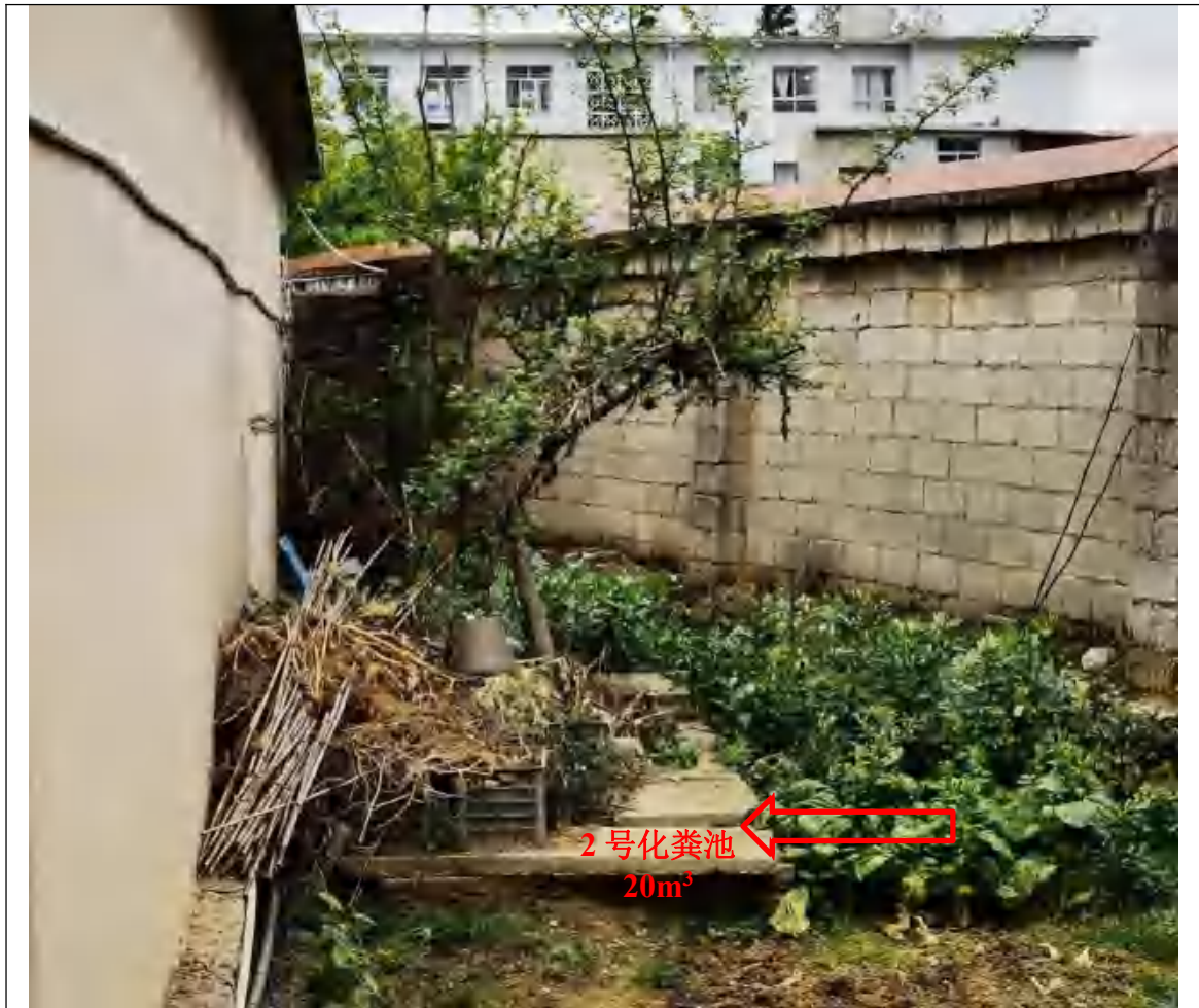
图 4-3 贵安新区马场中心小学现场照片
